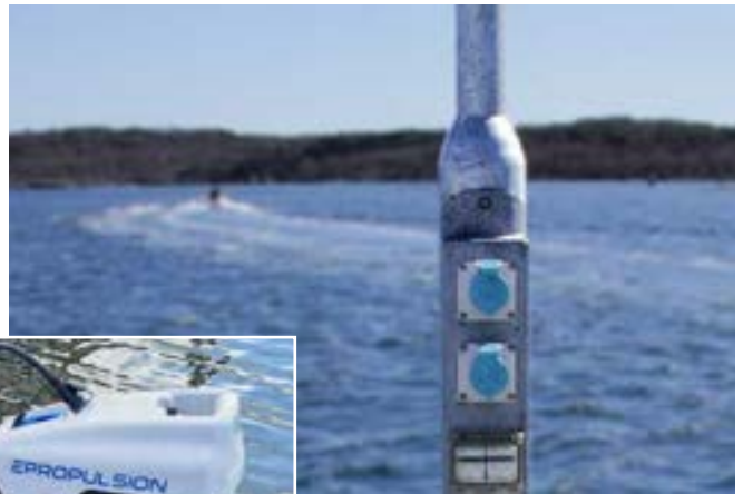
Liten elmotor, och exempel på enklare laddstolpe monterad ute på en brygga (större elmotorer kräver särskilda laddstolpar)
