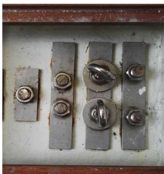
Kölbultar utan spår av korrosion
