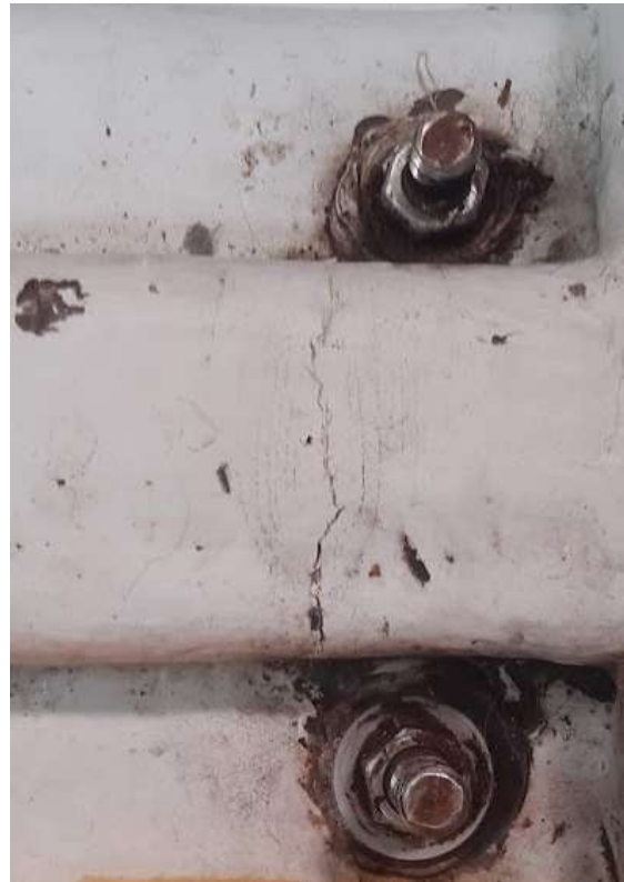
Bottenstockar med misstänkta skador
