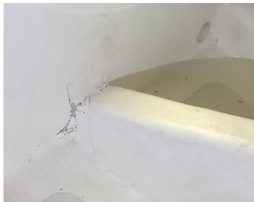
Bottenstock-kojfront efter grundsstötning
