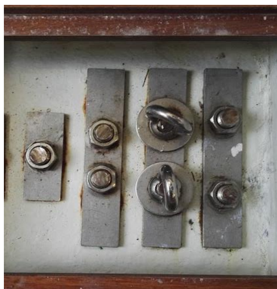
Kölbultar utan spår av korrosion
